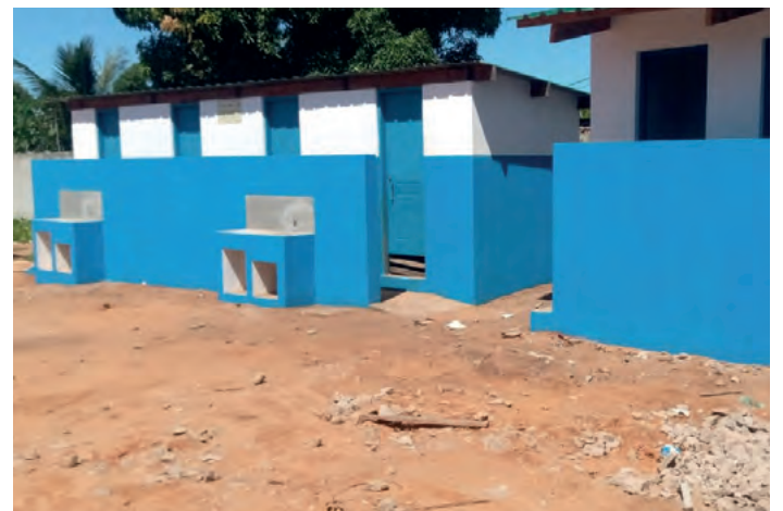
■ Die Grundschule in Muxara verfügt nun über einen adequate Wasserversorgung und WC-Anlagen.
