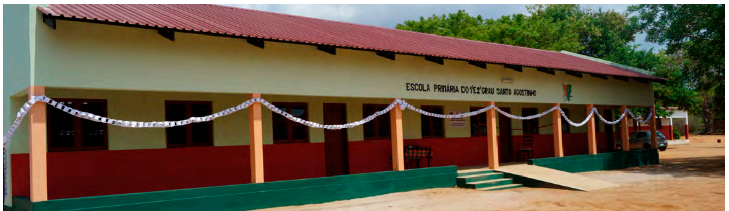
Im Oktober 2022 wurden die neuen Klassenzimmer in Mapinhane feierlich eingeweiht.
