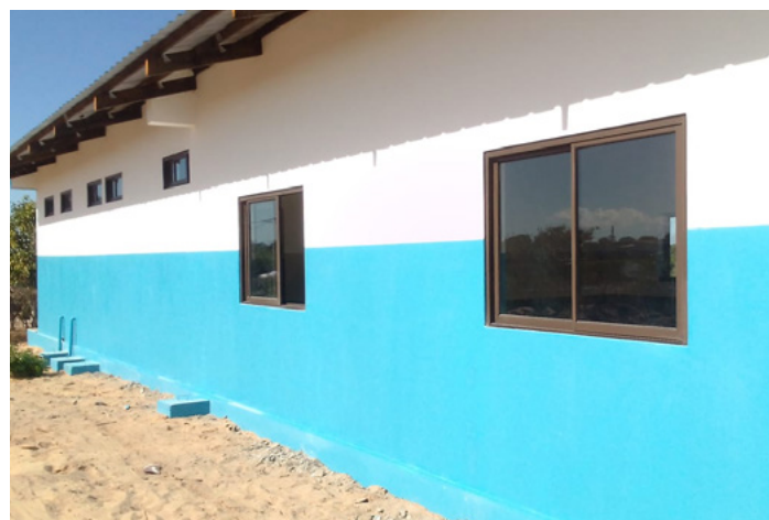
■ Edifício da Escola para Formação de Técnicos de saúde.
