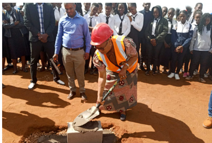
■ A administradora de Massingir Esmeralda Mutemba colocou a primeira pedra para construção das novas salas de aula na Escola Secundária Graça Machel.
