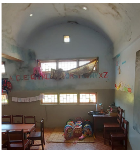
■ Der Vorschulkindergarten in Vilankulo vor der Sanierung.
